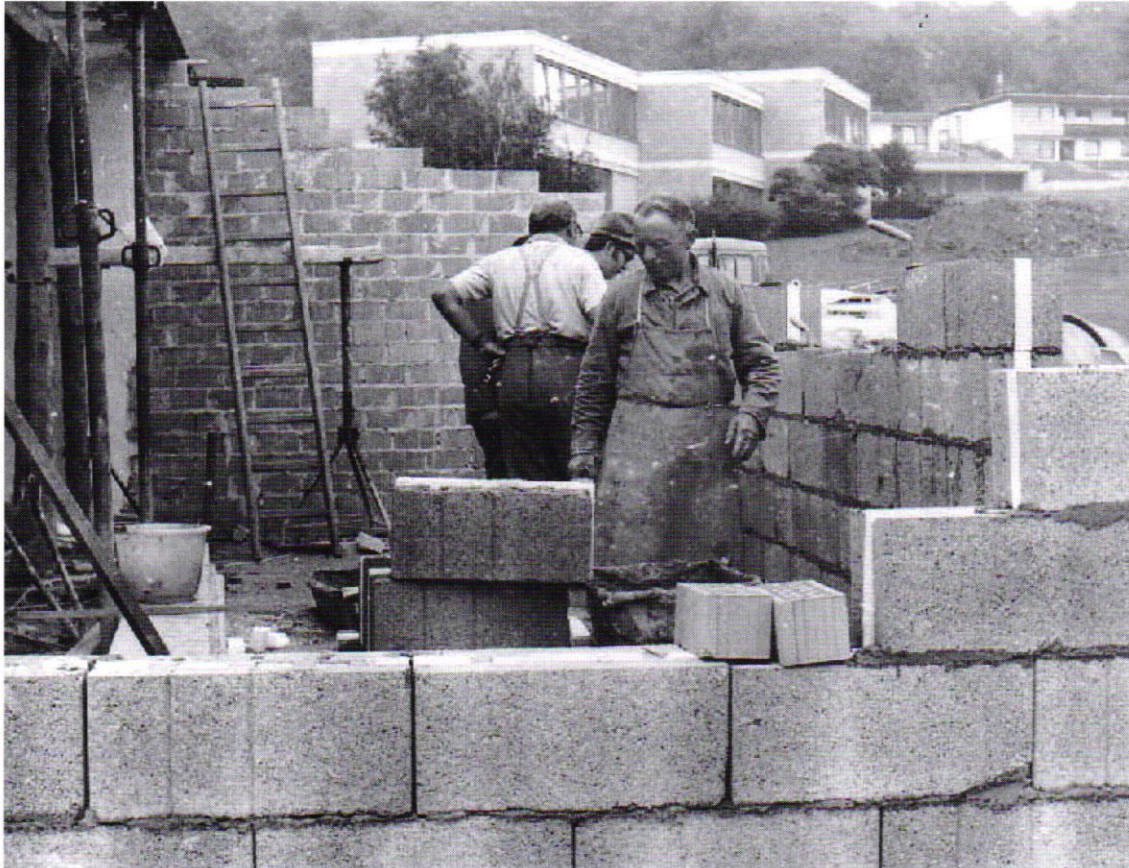
Vergrößerung des Sanitärbereichs der Buchenbachhalle 1968 Gottlob Schwarz und Erich Kögel beim Mauern
