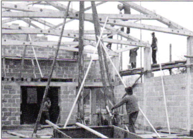
Beim Aufrichten der vorgefertigten Dachbinder unter Regie von Zimmermeister Gustav Bihlmayer aus Winnenden
